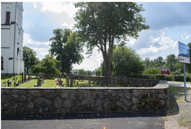
Den vällagda muren har ett rundat hörn mot landsvägskorsningen i nordväst.
